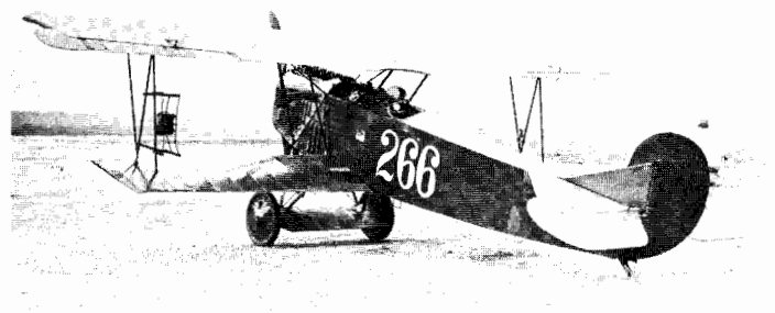
De 266 op Soesterberg. Aan de rechter vleugelstijlen is een snelheidsmeter bevestigd. Onder: De 266 als weervliegtuig in 1920-21. De zelfregistrerende instrumenten zijn aan de linker vleugelstijlen bevestigd.
